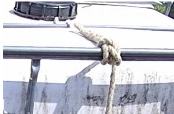
Abb. 20: Sicherung Tauchpumpe Festpunkt
