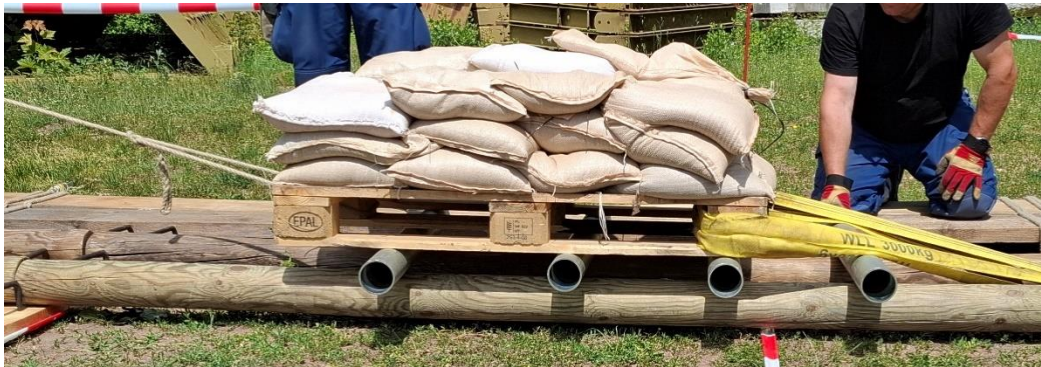
Abb. 15: Nachsetzen der Rollen vom Steg aus, Bremsleine auf Spannung (links)
