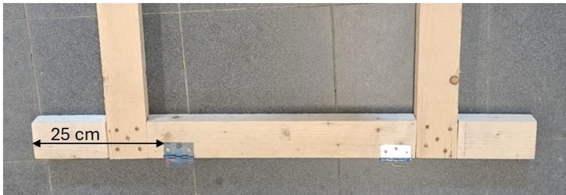
Abb. 28: Anbringung Scharnier, jeweils 25 cm Abstand zwischen Scharnieraußenkante und Außenkante Holz
